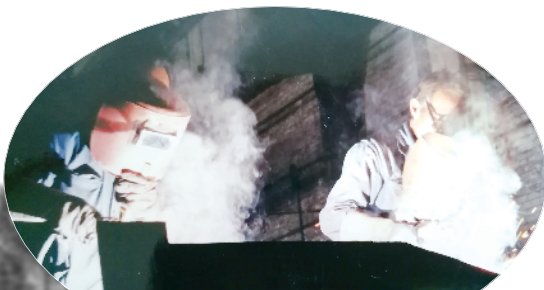
1980年除夕夜, 蒙焊车间的电焊工正在精心完成重点工序的装甲板焊接任务。
