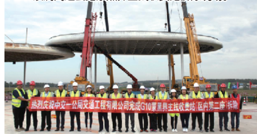
交通部、路政监察总队、总监办等领导亲临 G10绥满高速公路蒙黑界主线收费站拆除现场。
