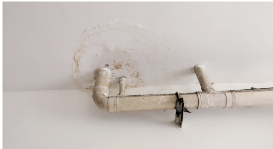
管道堵塞致房顶出现漏水 摄影/北方新报正北方网记者 张巧珍
