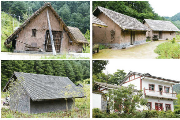
这张拼版照片显示的是贵州省赫章县海雀村的“四代房”:左上图为第一代杈杈房、右上图为第二代土坯房、左下图为第三代石墙房、右下图为第四代黔西北民居(图片均为2019年7月25日摄)
