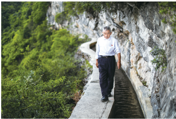
黄大发沿着修建在绝壁上的“大发渠”巡查(2018年8月11日摄)
