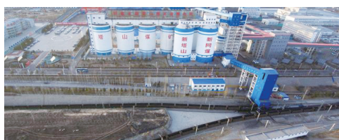
这是2018年12月5日拍摄的晋能控股集团塔山煤矿。
