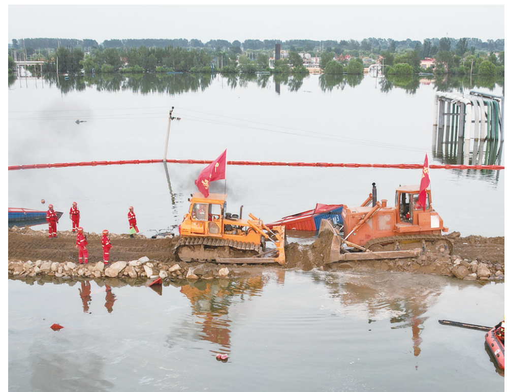
8月6日,抢险人员在溃口处完成合龙作业。
