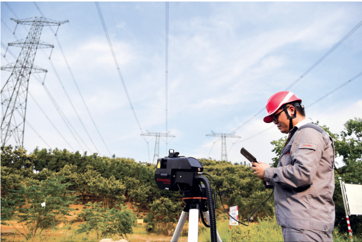
近日,安徽省持续高温天气,电力保供负荷较大。图为8月11日,安徽送变电工程有限公司广德运检站运维人员在调控电网异物远程清除器。 摄影/新华社记者 杜宇
