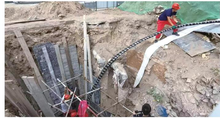
眼。只见施工人员将一条DN300内衬软管一端的端口塞进管网,随着牵引钢筋绳的不断收紧,内衬软管缓缓送入地下管道。
