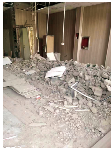
公寓楼门厅被改造
