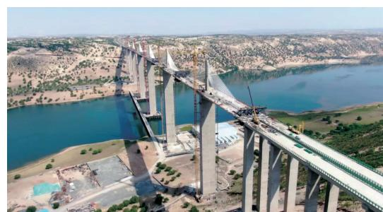
6月17日凌晨,由中交路桥建设有限公司承建的内蒙古自治区重点项目经(棚)乌(兰布统)高速公路控制性工程西拉沐伦特大桥顺利完成合龙段浇筑作业(如图),预计
