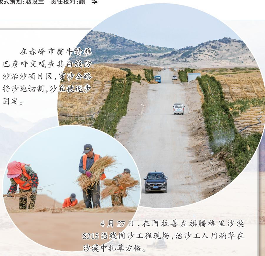
4月27日,在阿拉善左旗腾格里沙漠S315沿线固沙工程现场,治沙工人用稻草在沙漠中扎草方格。
