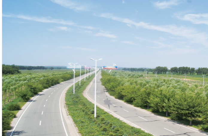
改造后宽阔的机场路。
