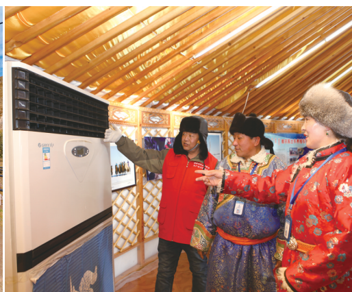
克什克腾旗供电公司党员服务队为“银冬轮”文化节供电。麻继鸿 摄
