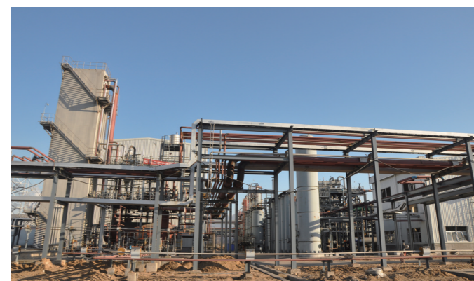
华信煤焦化焦炉尾气制LNG项目基本建成。郝隄 摄
