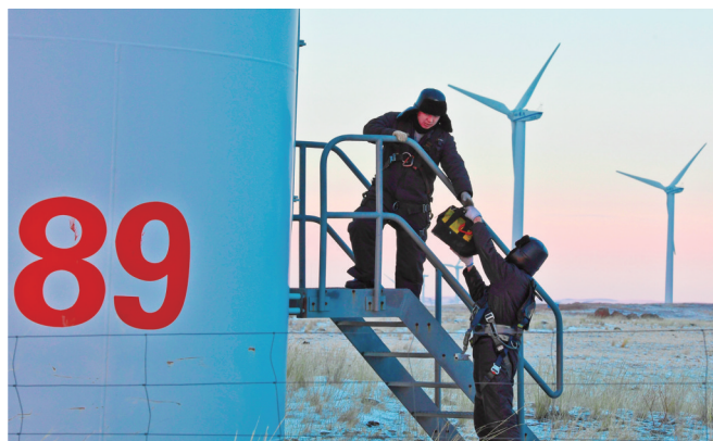
1月29日,位于锡林浩特市南45公里处的中广核新能源内蒙古分公司宝力格风电场技术人员正在抢修风机。
