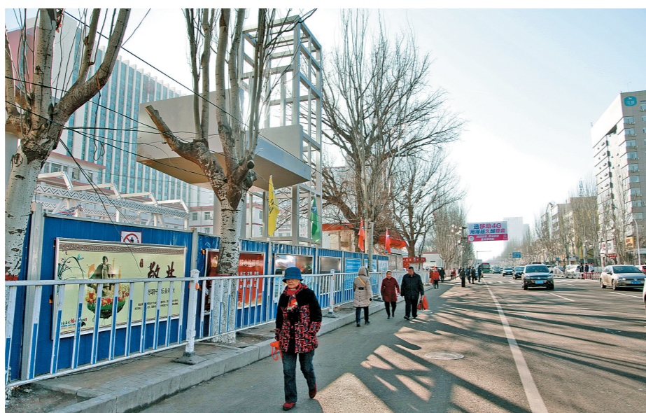
首府首座 铝合金天桥 即将完成施工
