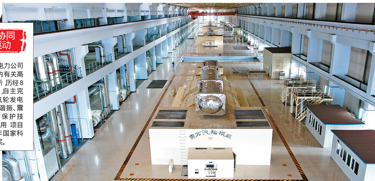
上都电厂汽轮机厂房全景。
