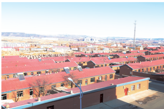
棚户区改造工程——16号街坊。
