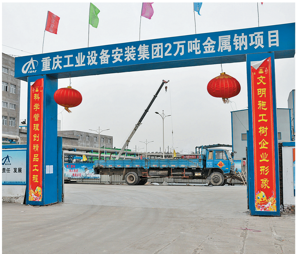
2万吨工业金属钠项目建设工地外景。
