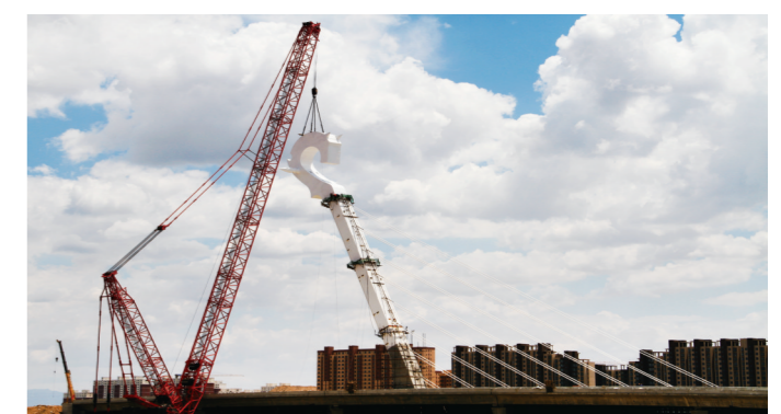
为打造祖国北疆亮丽风景线,中国二冶在呼和浩特城市建设中演绎经典。图为中国二冶承建的呼和浩特市敕勒川大街东大桥工程。
