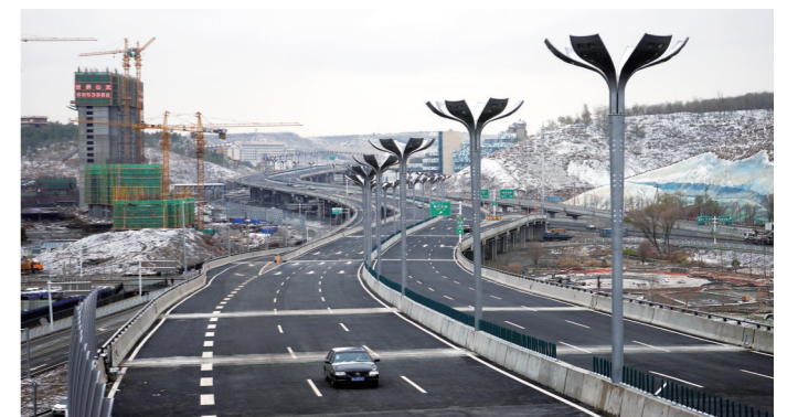
中国二冶在道桥工程建设中捧杯折桂。图为中国二冶建设并荣获 新疆金杯示范工程 的乌鲁木齐南高架桥工程。
