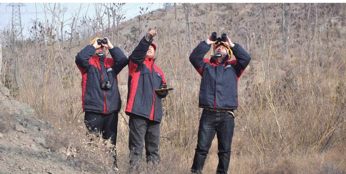
乌海电业局输电处的工人在山里巡检线路。海东 摄
