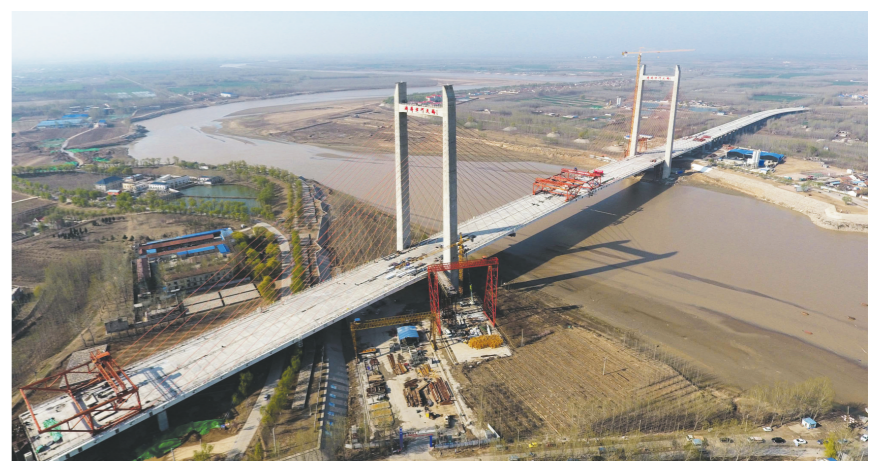
济齐黄河公路大桥完成合龙
