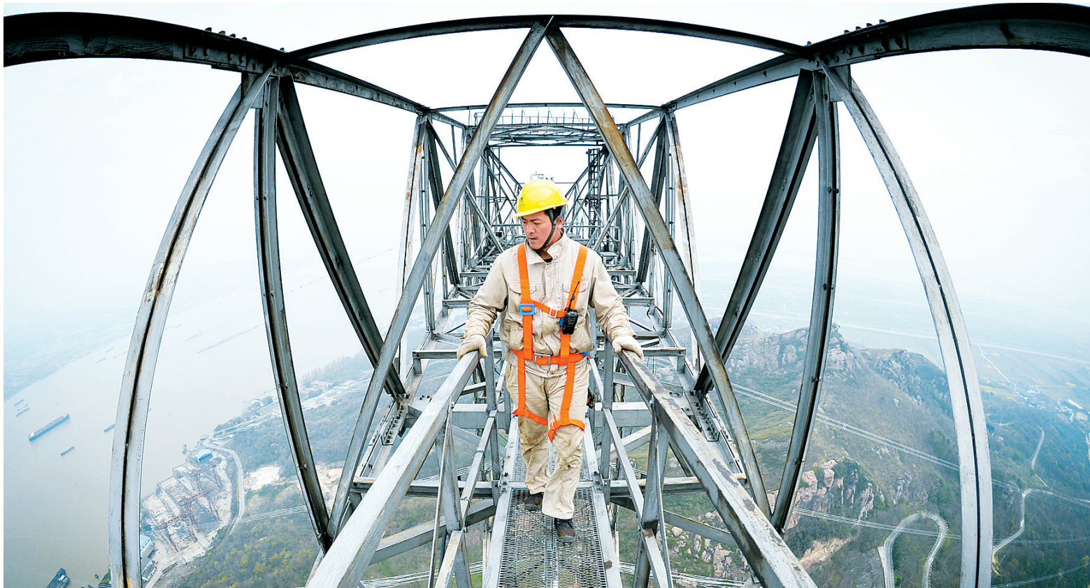
江苏镇江:“长江大跨越”输电线路换线增容
