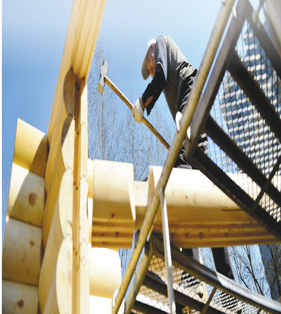
工人正在锡林公园木屋综合体施工。
