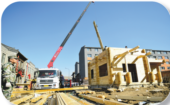
位于玉泉区烧麦第一街西口路南的木屋综合体正在紧张施工中。
