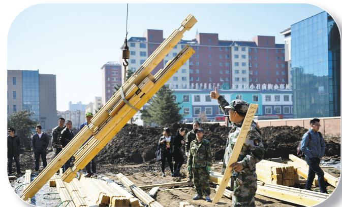
施工现场,吊装木材。
