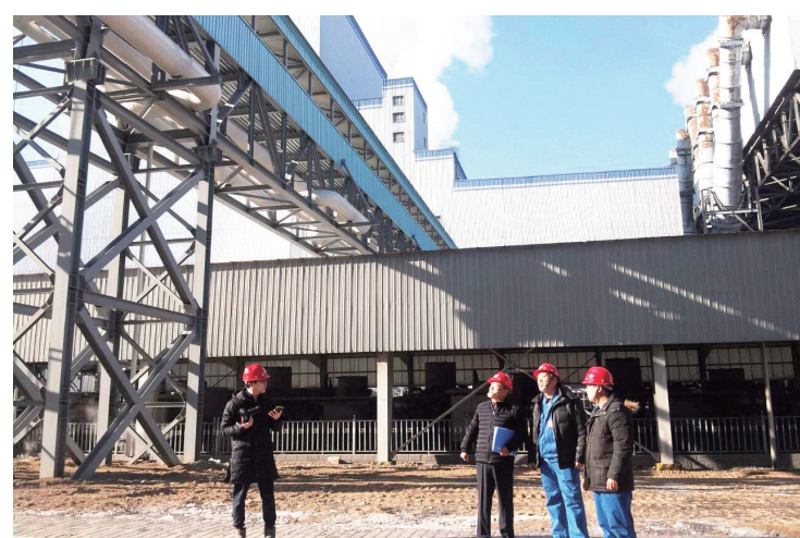
大唐托电厂区。
