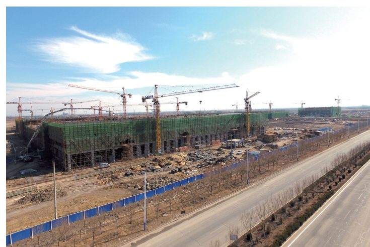
沃特玛项目施工现场。
