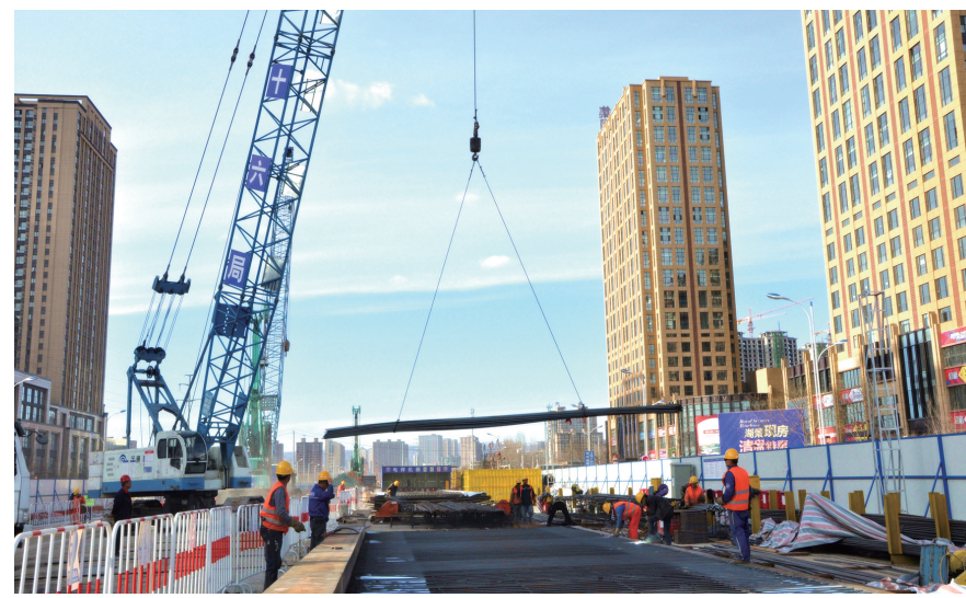
地铁施工现场。
