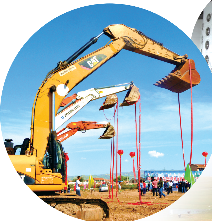
乌里沙河综合整治工程开工现场。
