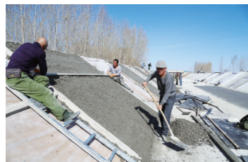
在绰勒水利枢纽下游灌区工人们正在混凝土衬砌。白玉亮 摄
