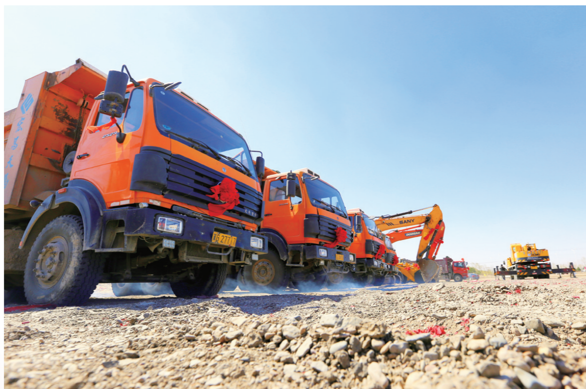
兴安职业技术学院新校区建设项目。孙璞玉 摄
