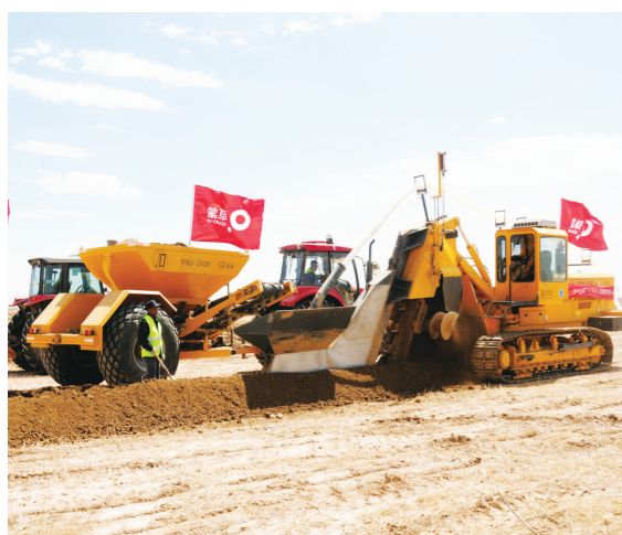
五原县百万亩盐碱化耕地改盐增草(饲)兴牧工程施工现场。
