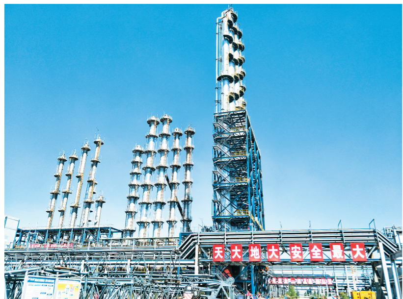
鄂尔多斯8000吨太阳能级多晶硅改扩建项目建设现场。本报记者 李永桃 摄
