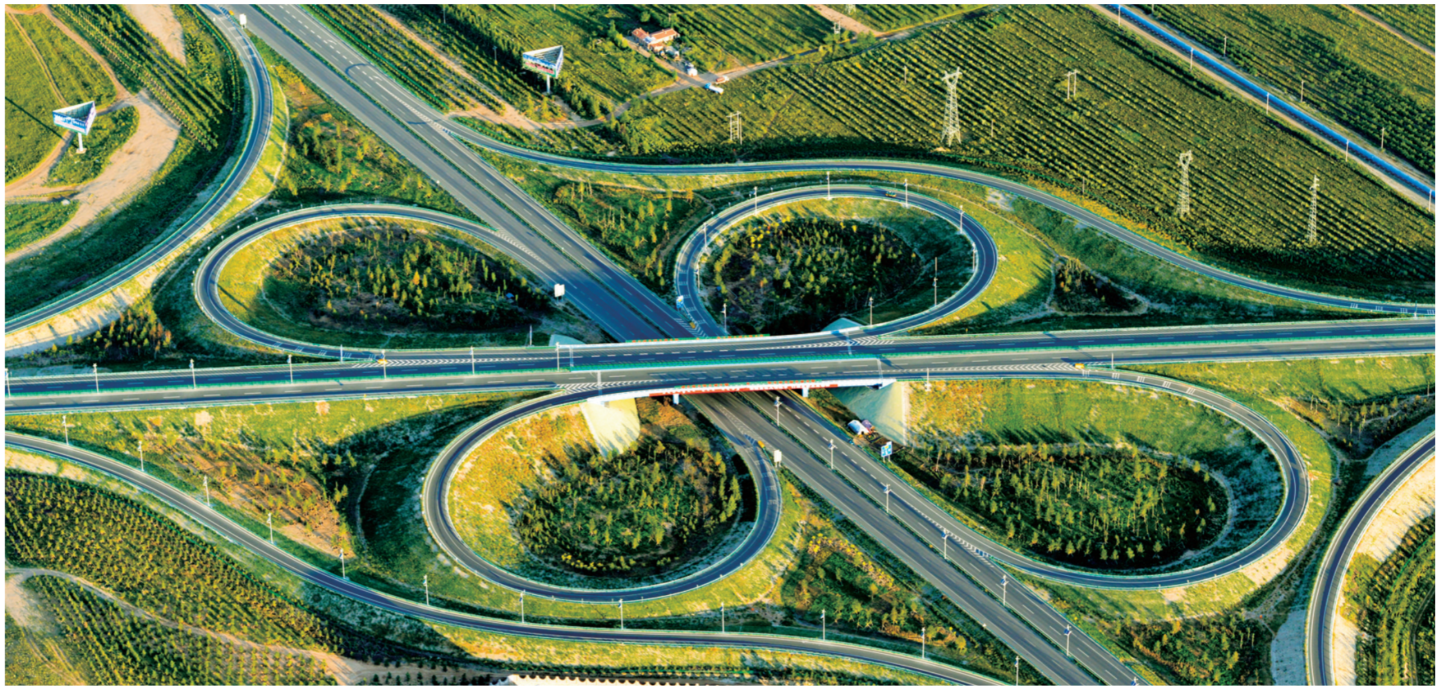
高速公路立交桥。
