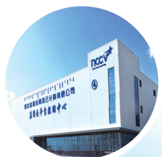
应用云平台+号数据机房。
