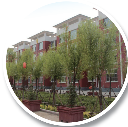
凉城县岱海镇海城村移民搬迁安置点。
