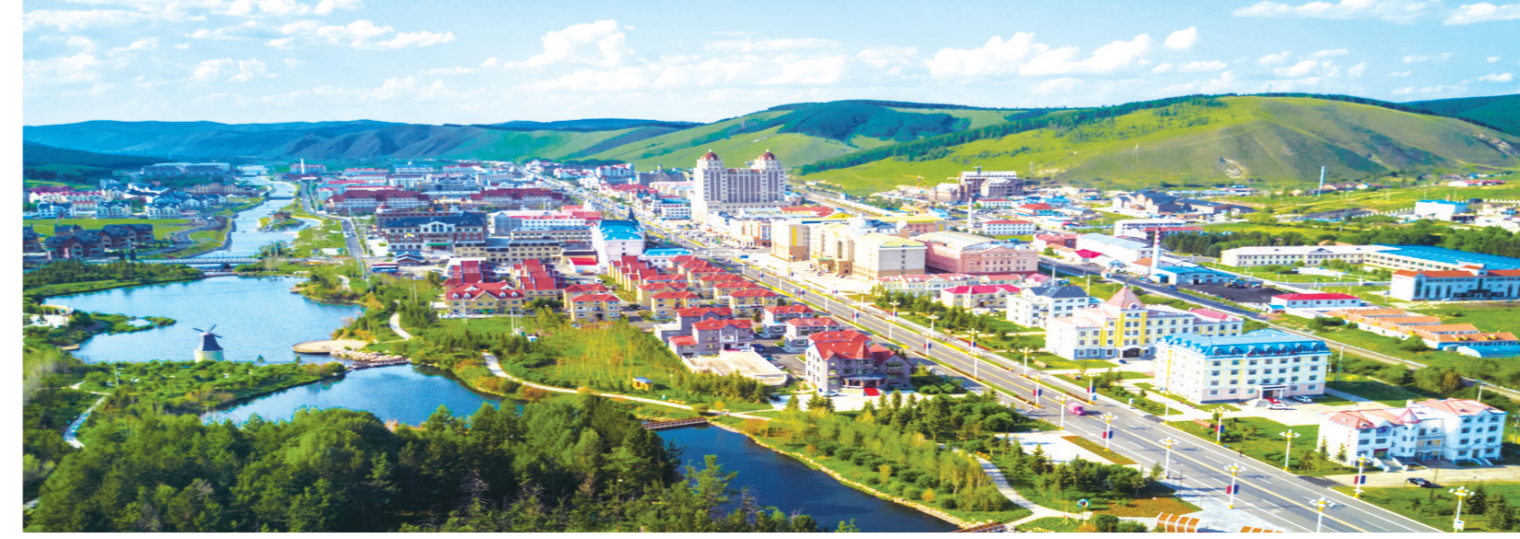
70年来,全盟基础设施不断完善,城乡面貌日新月异。图为,塞外明珠阿尔山。 毕力格 摄
