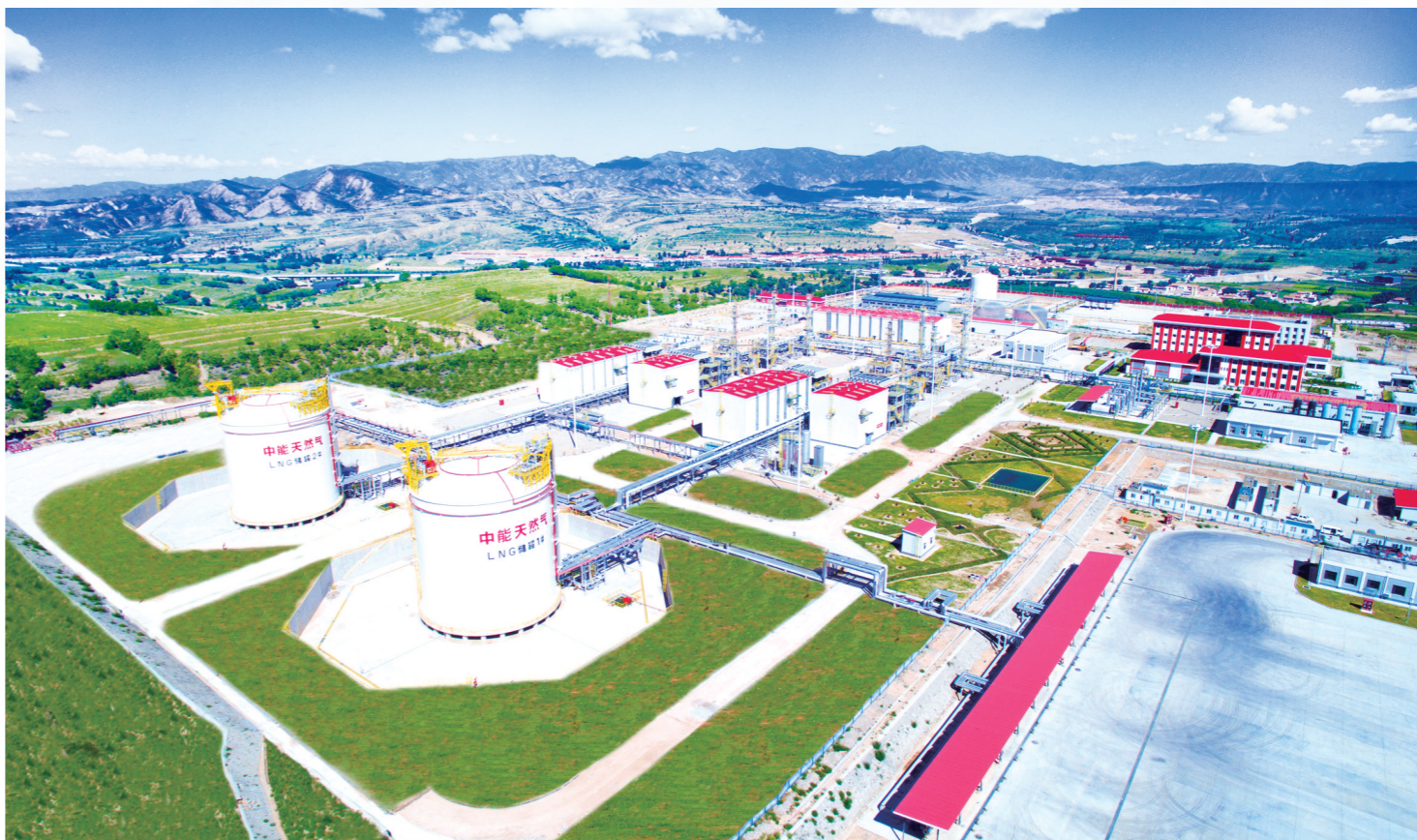
项目建设,稳扎稳打,厂区面貌气势恢宏。
