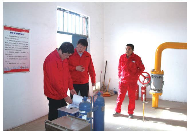
内蒙古西部天然气股份有限公司主要领导实地检查,压实安全责任。
