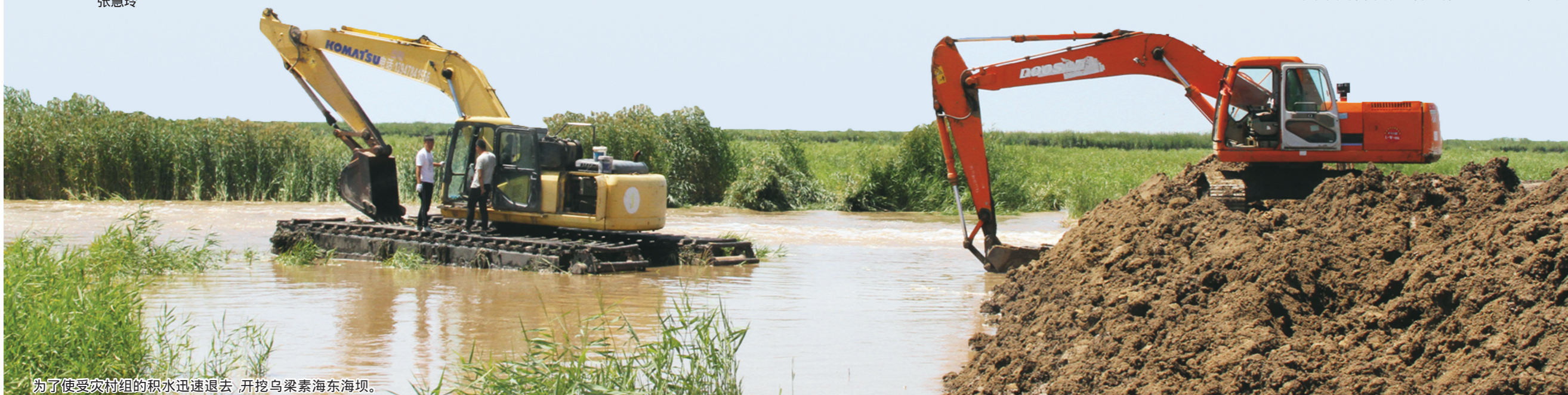
为了使受灾村组的积水迅速退去，开挖乌梁素海东海坝。
