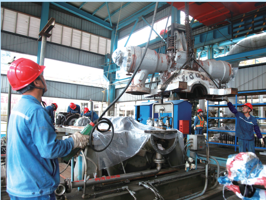
呼石化三修车间员工检修催化裂化装置气压机。
