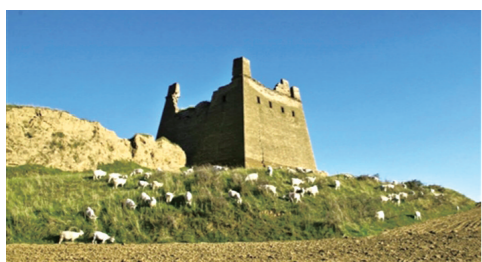
位于清水河县的明长城箭牌楼。
