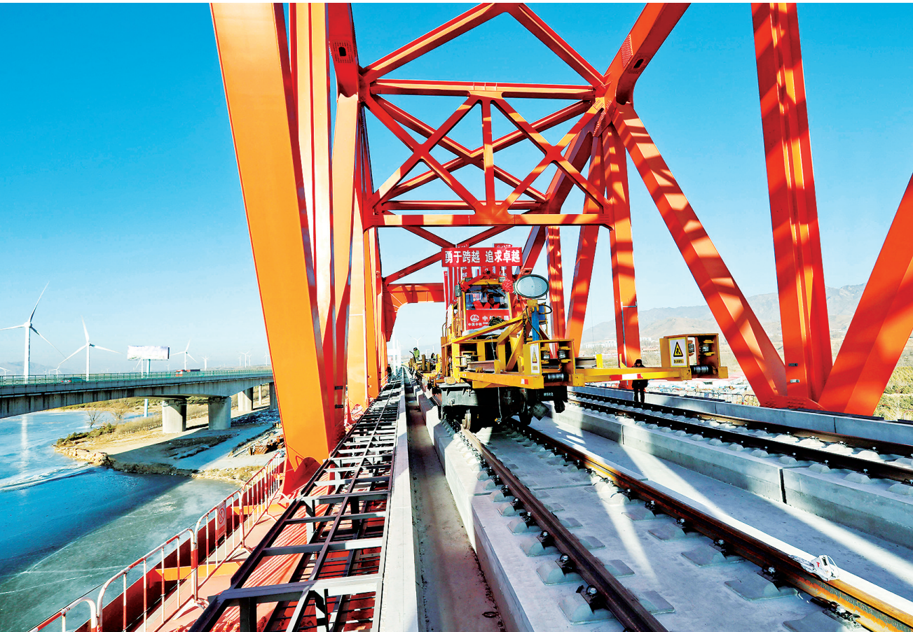
京张高铁官厅水库特大桥铺轨
