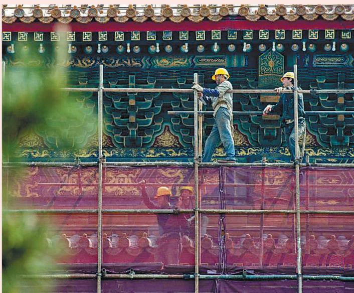
施工人员在天安门城楼搭设脚手架。
