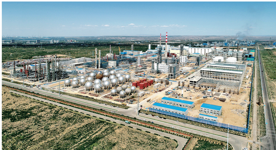
久泰能源有限公司在建的60万吨甲醇深加工项目。
