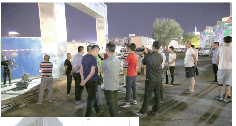
各部门联合夜查施工工地环保措施。
