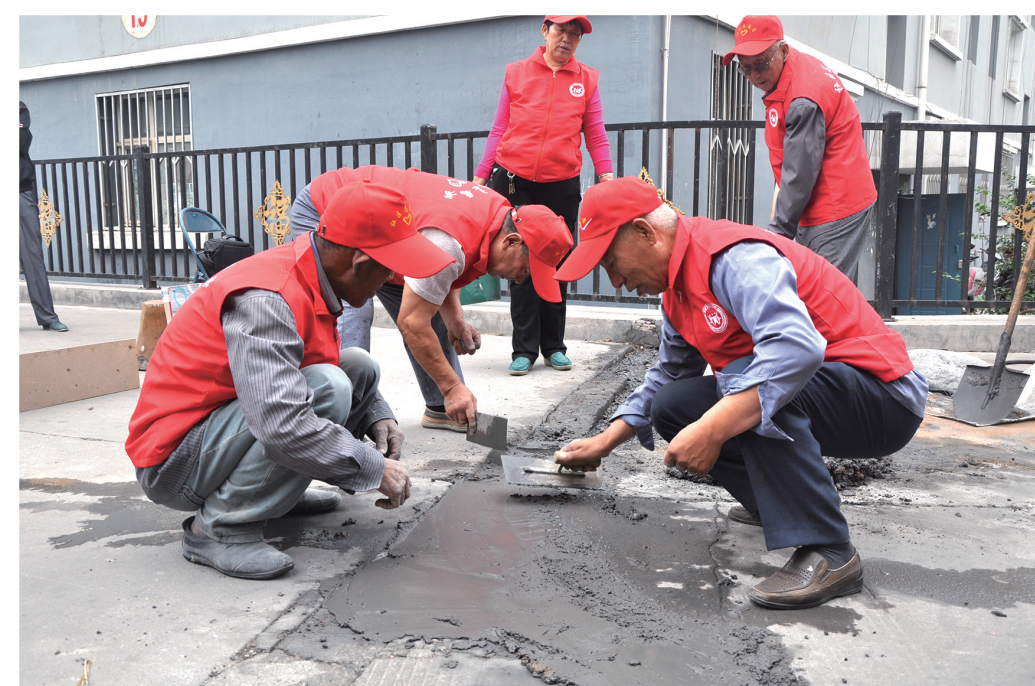
社区志愿者主动整修小区内破损道路。郝鹏 摄
