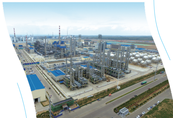
大路工业园区久泰60万吨甲醇制烯烃项目厂区。
