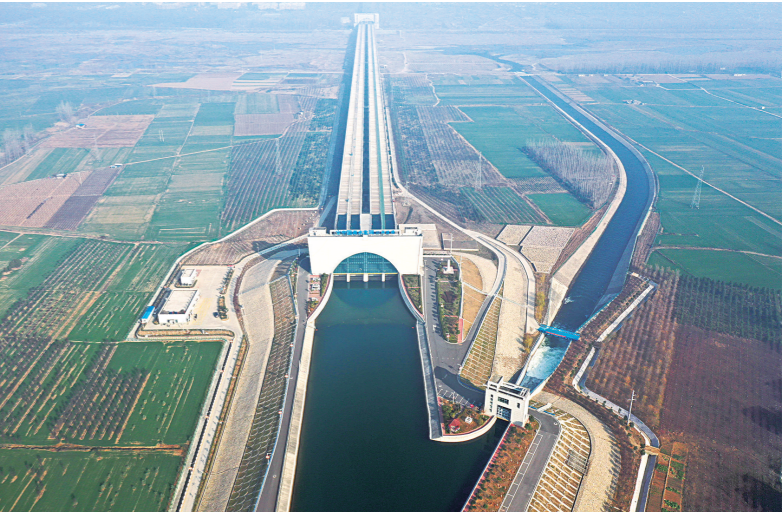
冬日俯瞰沙河渡槽
