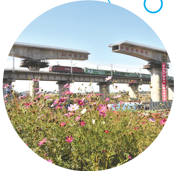
2015年9月23日,张呼高铁跨张集线转体桥。纪恩泉 摄
