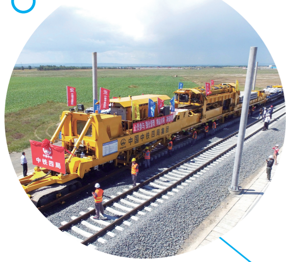
2016年9月12日,铁路建设者利用CFG-500型长轨铺轨机对张呼高铁东段进行铺轨作业。(资料照片)
