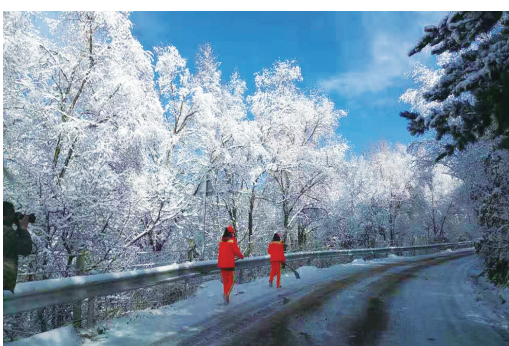
喀喇沁旗农村公路养护。
