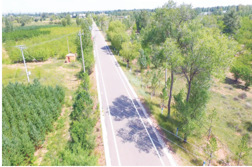
伊金霍洛旗老虎渠通村路。
