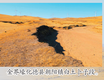
金界壕化德县朝阳镇白土卜子段。
