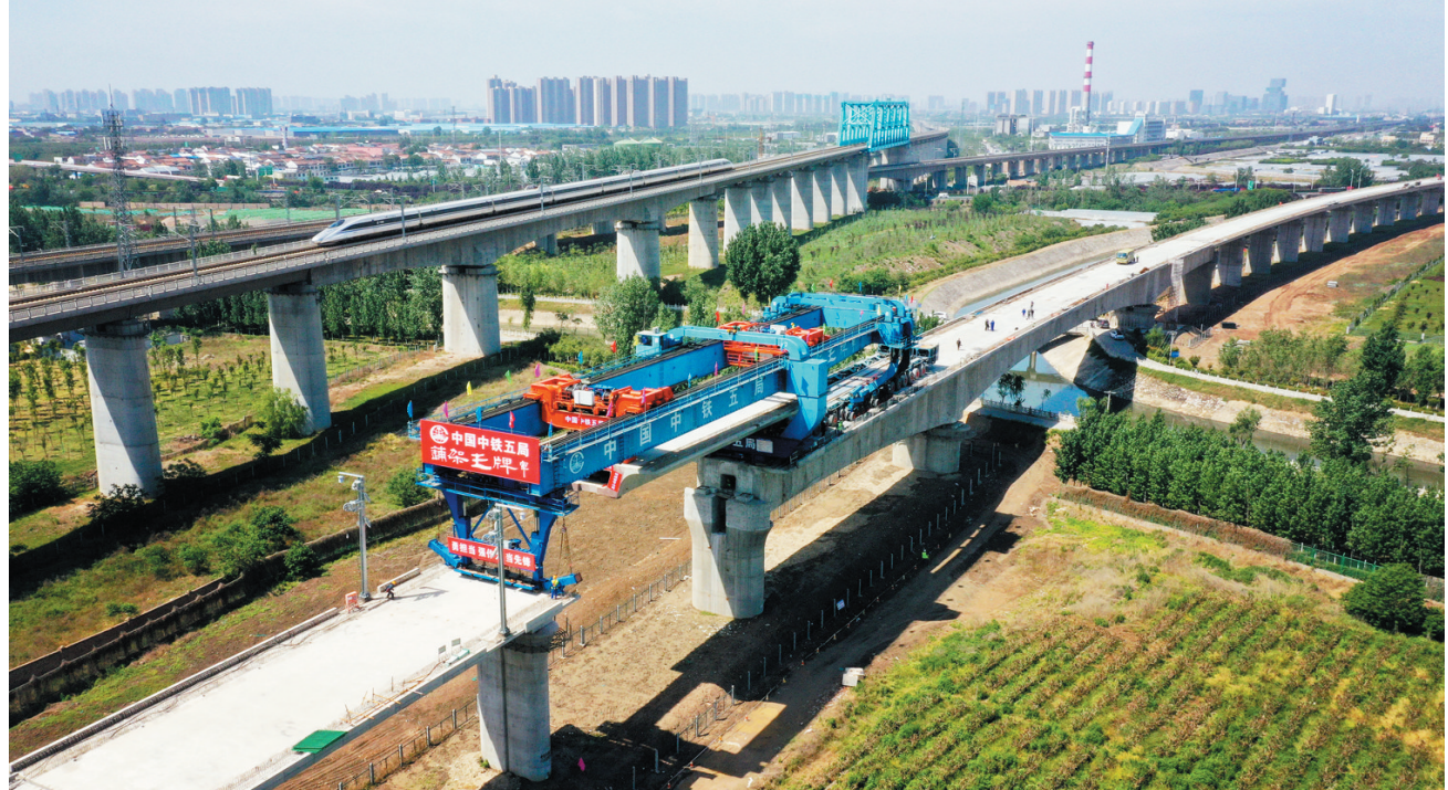
银西高铁全线箱梁架设任务完成
