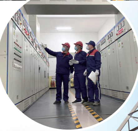
电力员工为企业进行复工前配电网设备安全检查。
