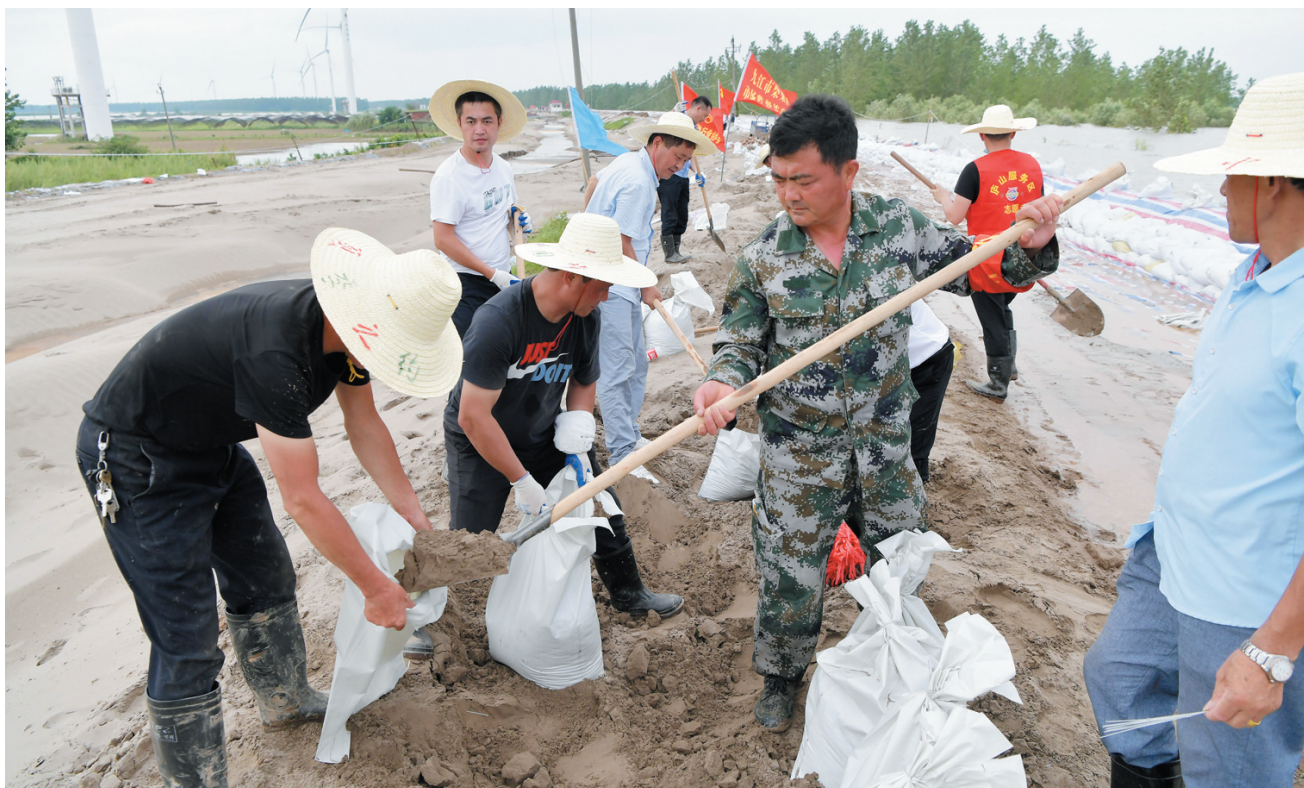
江洲镇柳洲村村支书洪棉雪(前右二)和村民、支援人员一起装沙袋 加固堤坝。 新华社记者 彭昭之 摄
