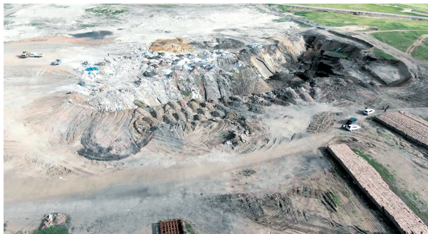
建筑垃圾填埋场全貌。
